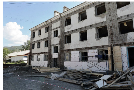
Дом на Школьной, где идет ремонт по программе сейсмоусиления
